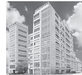
※右から本館・6号館
